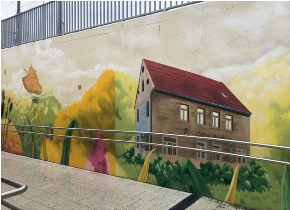
Ø3 Rampe des neuen westlichen Zugangs (Anfang 2024)
