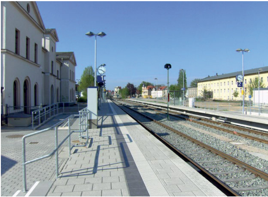
Ø4 Bahnhofsgebäude Schmölln, mit Hausbahnsteig
