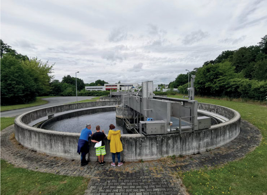
Ø5 Abwärmenutzung möglich: Kläranlage in Schmölln
